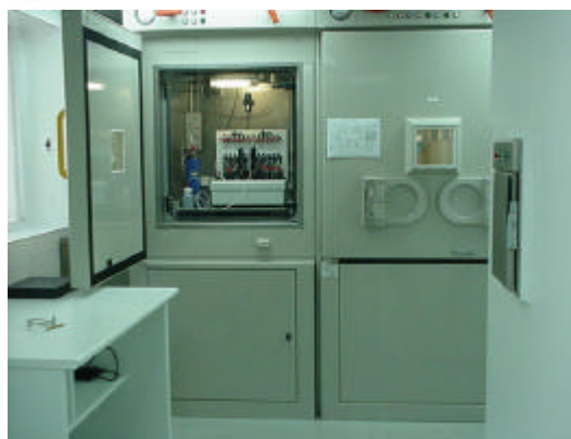
Zona de síntesis y acondicionamiento
